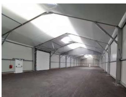
Atelier et stockage | 900 m 2 | location 32 mois
