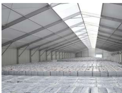
Bâtiment stockage | 5000 m 2 | location 36 mois
