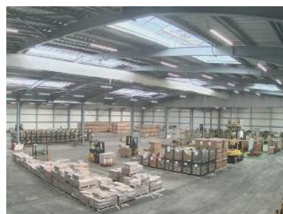
Bâtiment stockage | 4160 m 2 | location 120 mois
