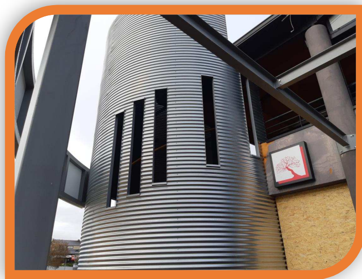
Tôles ondulées cintrées pour architecture
