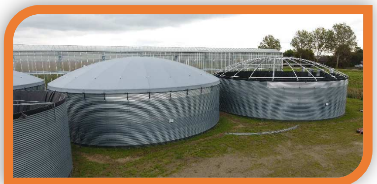
Couverture réserve d'eau
