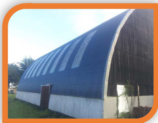
Couverture et bardage
