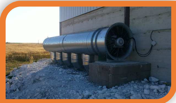
Collecteur d'air avec ventilateur axial
