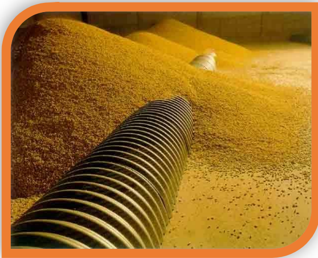
Gaines de ventilation céréales
