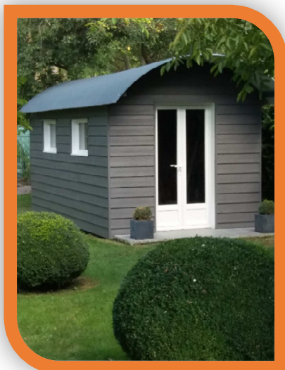
Toiture roulotte, abri de jardin, etc.
