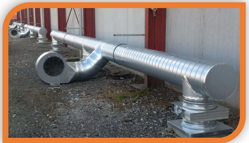
Collecteur d'air avec ventilateur centrifuge
