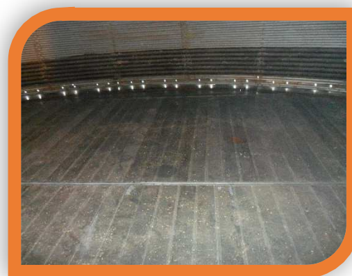
Ventilation par plancher perforé
