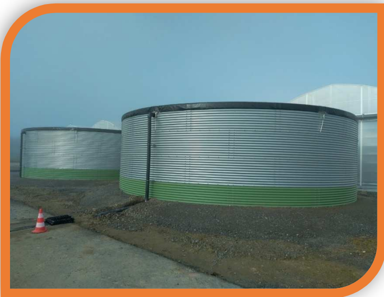
Réserve d'eau semi enterrée
