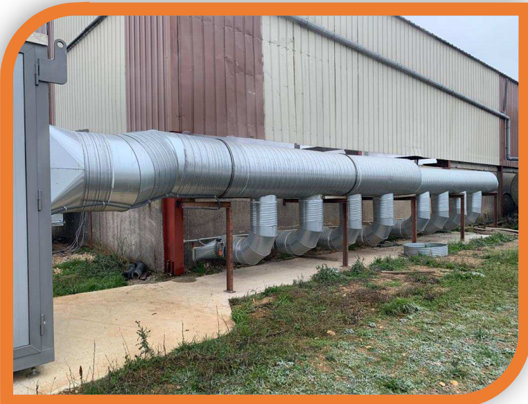
Collecteur d'air avec plancher perforé carrossable
