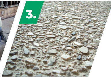
3. Sol après ponçage
