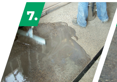
7. Étalez le mélange sur la surface à recouvrir
