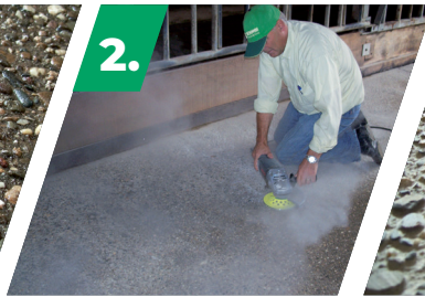
2. Poncez le sol si nécessaire
