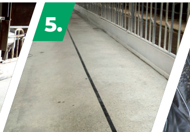
5. Délimitez la zone à recouvrir avec du ruban adhésif
