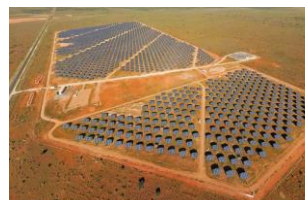
Centrales au sol
