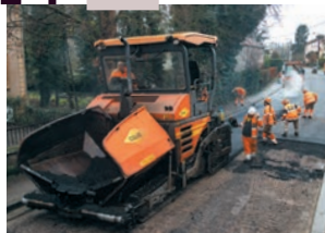
Chantiers de voirie
