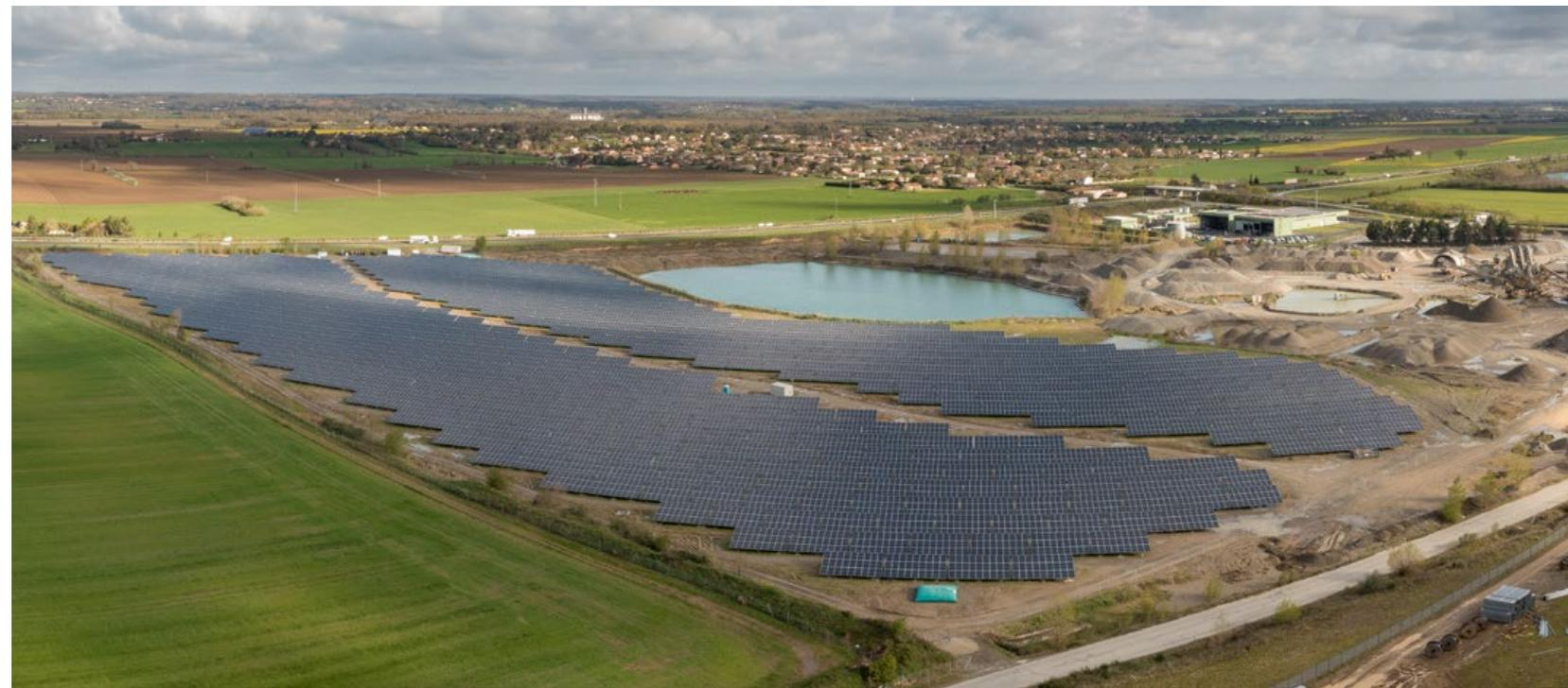
→ Les **19 278** panneaux du parc de La Fibat produisent environ **11 400 MWh** d'électricité par an.
