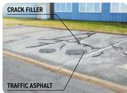
1. Bouchez les trous et les fissures
