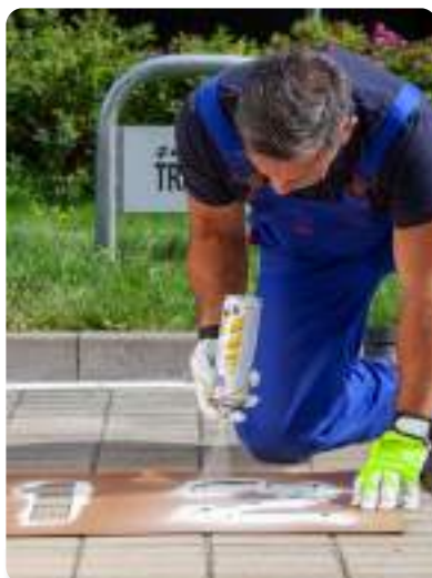
Application manuelle de la peinture TRAFFIC PAINT® avec un pochoir XL NUMBER
