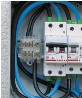
Z16-8D et Z6-6D montés sur des rails DIN. Utilisés dans les panneaux de contrôle
