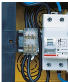
Z16-8D et Z6-6D montés sur des rails DIN. Utilisés dans les panneaux de contrôle
