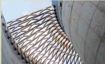
Nos systèmes de coffrage offrent une stabilité telle que nous sommes en mesure de monter nos coffrages intérieurs et extérieurs sans entretoises, ce qui nous permet de garantir une parfaite étanchéité de nos ouvrages.
