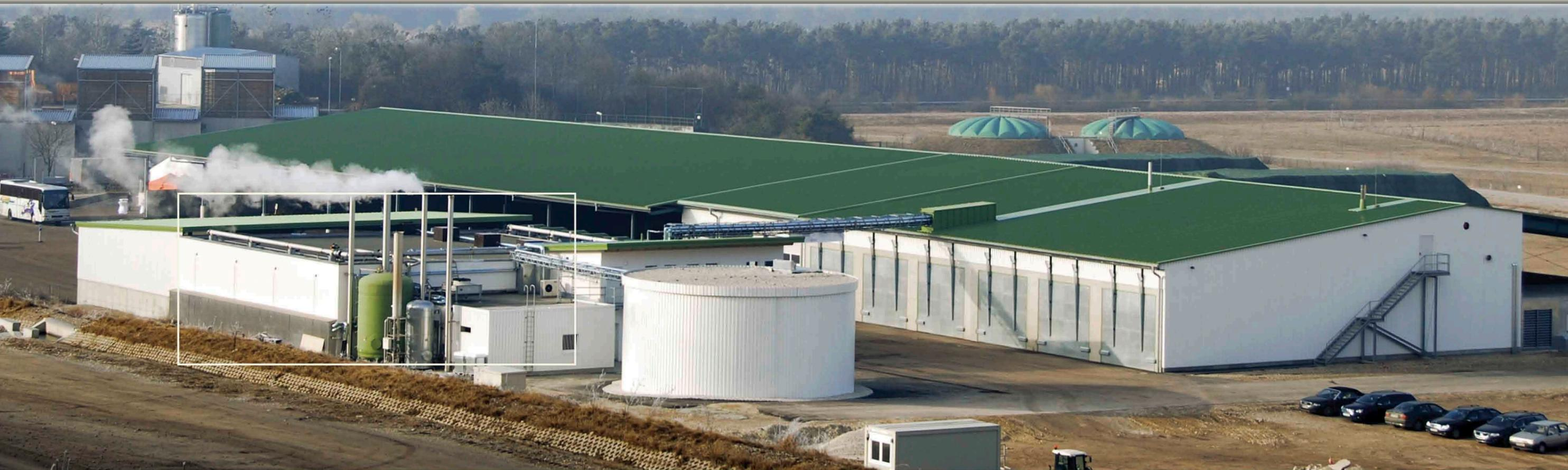
Système Wolf construit, en plus des réservoirs circulaires en béton armé, des méthaniseurs de forme rectangulaire (photo ci-dessus) et les bâtiments nécessaires pour la production de biogaz pour l'industrie, les communes et l'agriculture.
