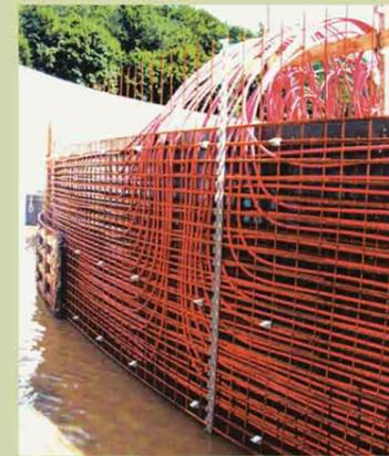
Chauffage des parois de digesteur
