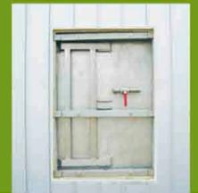
Porte de réservoir étanche au gaz et aux liquides pour les travaux d'entretien
