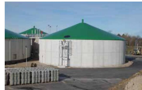
Toit pour biogaz sur réservoir en béton armé
