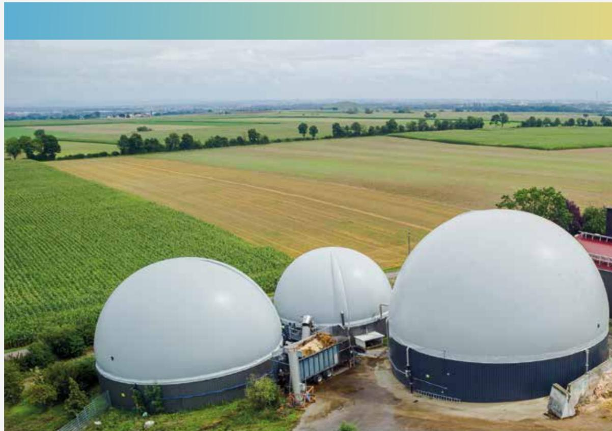
Trois DMGS avec système Airflow de 550 m<sup>3</sup>, 1210 m<sup>3</sup> et 2590 m<sup>3</sup> volume de stockage
