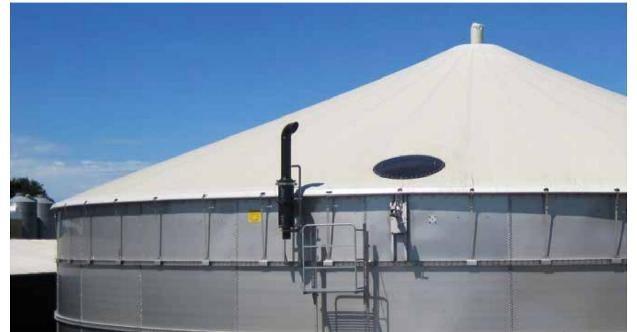
Toit pour biogaz sur réservoir en acier inoxydable
