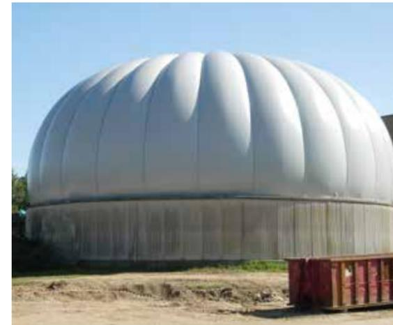
Réservoir de 50 %, 2850 m<sup>3</sup>, 35 mbar de pression
