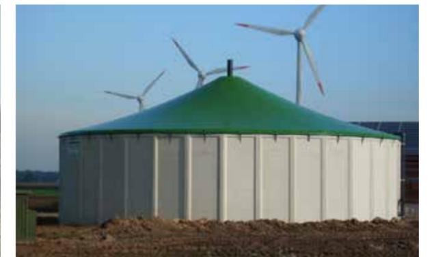
Toit pour biogaz sur réservoir en béton préfabriqué
