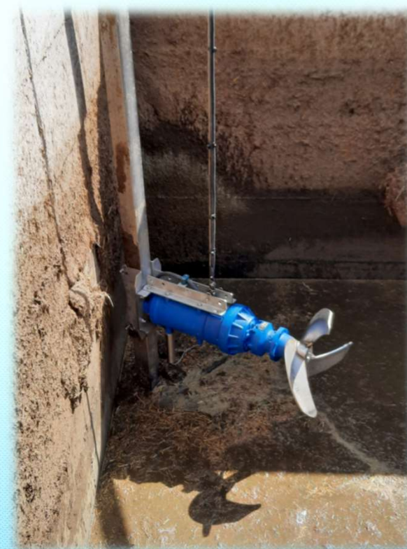
SE submersible agitator 7,5 kW
