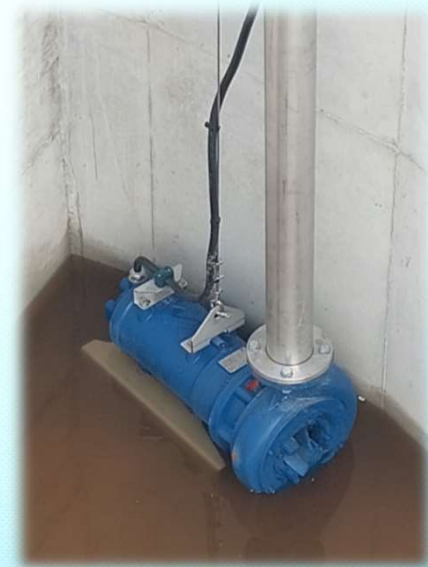
SPB submersible pump 7,5 kW
