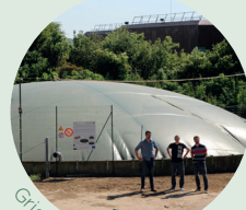
22MW, méthanisation 150 QW, post-digester chauffé
