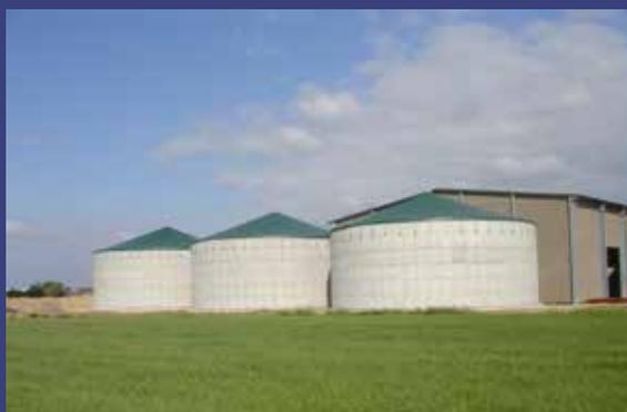
*“Un toit en béton pour résister aux gros tonnages; un toit en PVC pour retenir les odeurs”*
