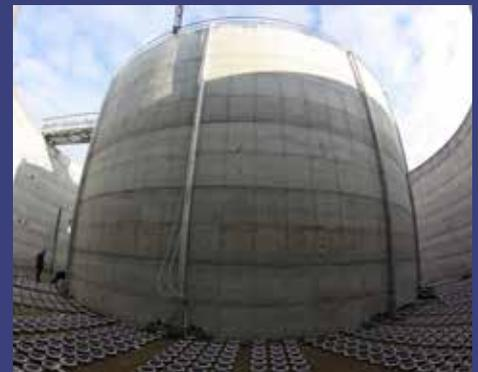
Pour une exécution économique, les bassins d’une installation d’épuration des eaux usées sont circulaires. L’exécution de constructions concentriques est plus avantageuse pour la réalisation de processus d’aération et combiné avec dénitrification. Pour les décanteurs, la conduite d’alimentation est bétonnée dans la colonne centrale. A la demande, Bio-Dynamics peut aussi livrer et installer les membranes d’aération, mixeurs bananes, ponts racleurs et goulottes.
