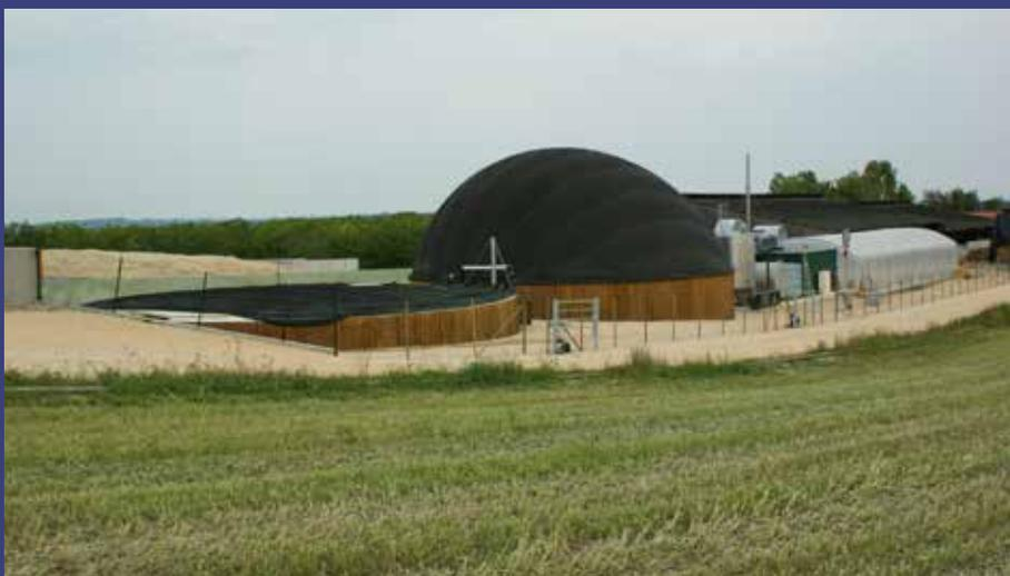
Bio-Dynamics construit des digesteurs mésophiles ou thermophiles pour des installations de biogaz industrielles ou à la ferme. Bio-Dynamics a la possibilité d'installer directement le réseau de chauffage dans les voiles béton ou dans les radiers des digesteurs. L'isolation extérieure et le revêtement anticorrosion intérieur du digesteur peuvent être réalisés en même temps que le coulage des voiles béton offrant une exécution parfaite avec grande rapidité.
