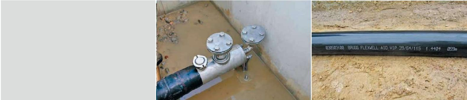
FLEXWELL® All-in-One est un tube pour GNL unique et d'un bon rapport coût-efficacité qui, dans les stations-services distribuant du GNL, est utilisé comme tube de transport, de recirculation et de gaz d'évaporation d'un seul tenant : All-in-One (tout en un) !
