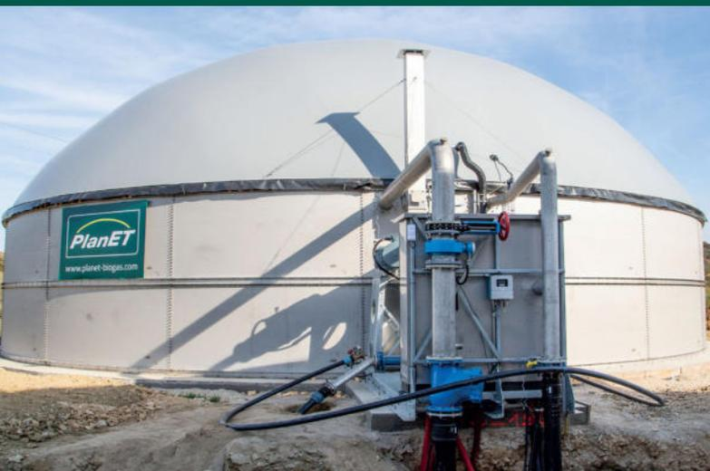
Réservoir en acier inoxydable - construction modulaire
