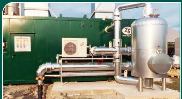
Ajout de traitement de biogaz sur installation existante
