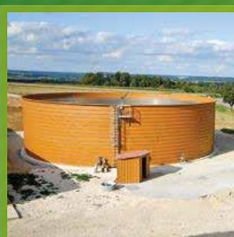
Avec chauffage et isolation, agitateurs et couverture double membrane.
