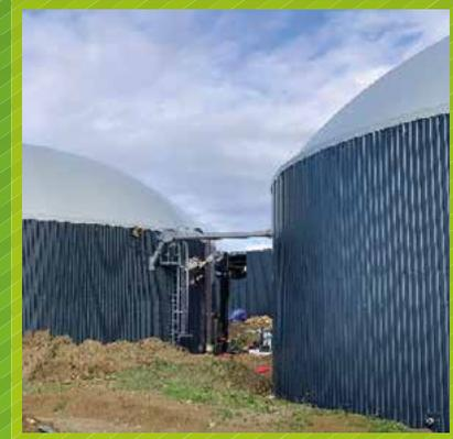
**Digesteur LIPP** - de 28 x 8 mètres avec agitateur Mammut et couverture BAUR FOLIEN
