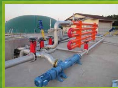
Pompes dilacératrices, échangeurs Bio-Heat
