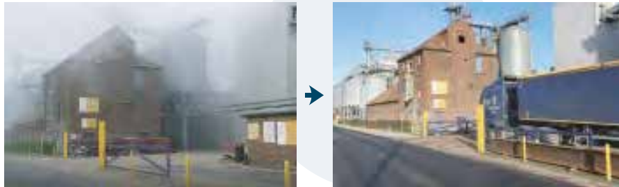
Émissions AVANT et APRES installation d'un système Centriair
