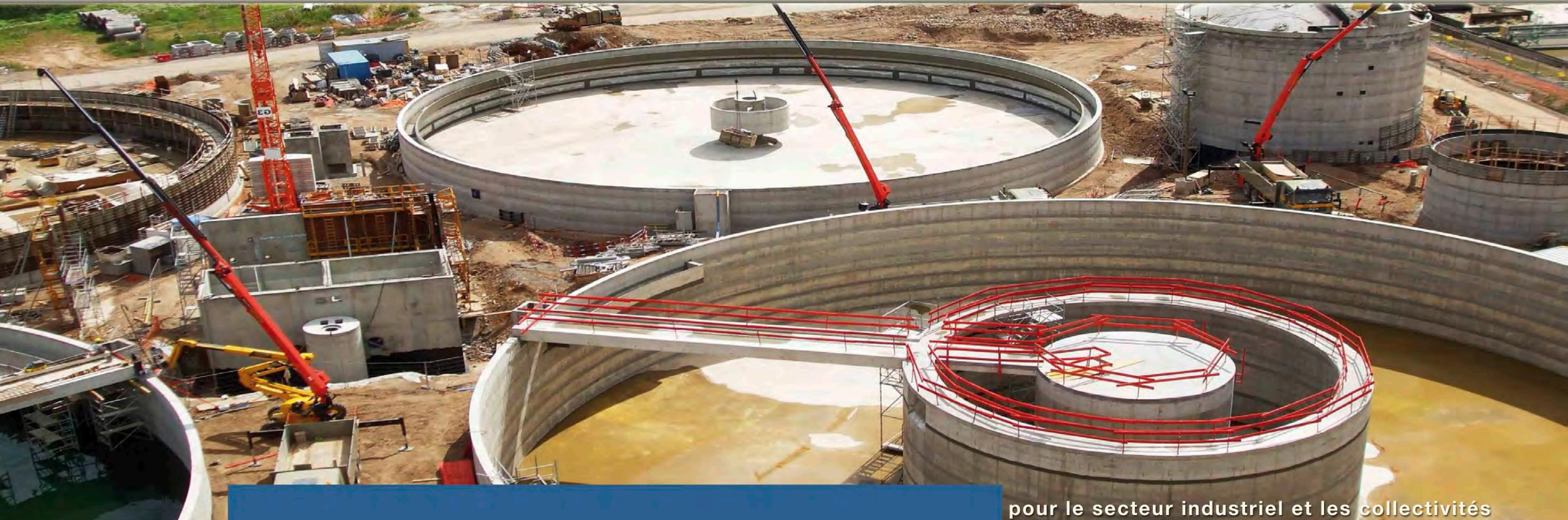
Réservoirs circulaires en béton armé Système Wolf
