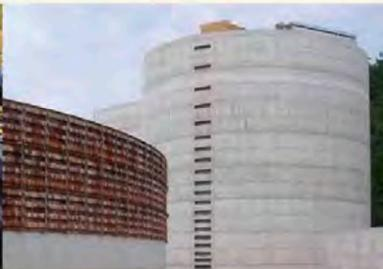
Réservoir en béton précontraint pour usages spécifiques
