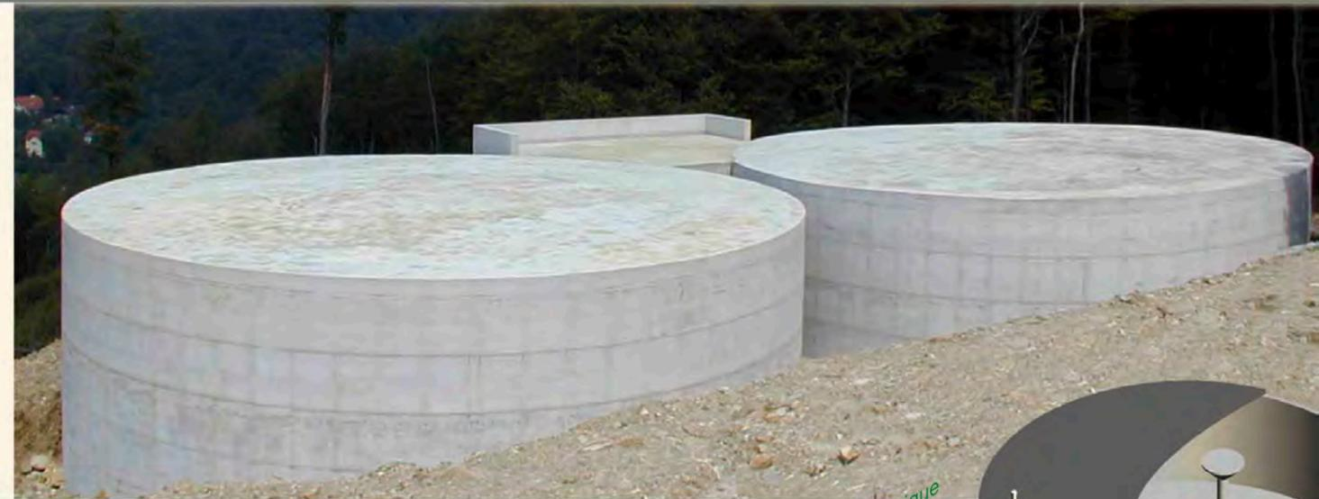
Réservoir d'eau potable (recouvert de terre)
