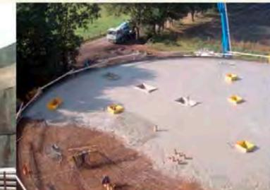
Ferrillage et bétonnage de la dalle de couverture du réservoir
