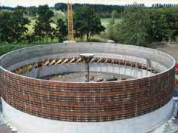
Pose des éléments préfabriqués de couverture
