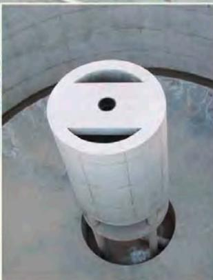
**Clarificateurs** - avec un radier en pente vers le milieu, fût central, entonnoir d'écoulement
