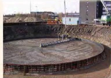
Coffrage, ferrillage et bétonnage du radier avec dispositif de lissage
