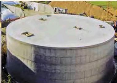
...le réservoir couvert en béton armé terminé
