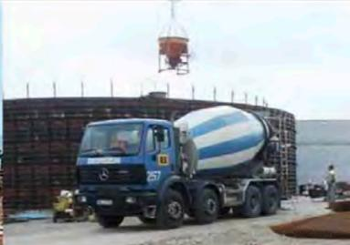
Bétonnage de la paroi du réservoir avec godet à chaussette ou chariot électrique
