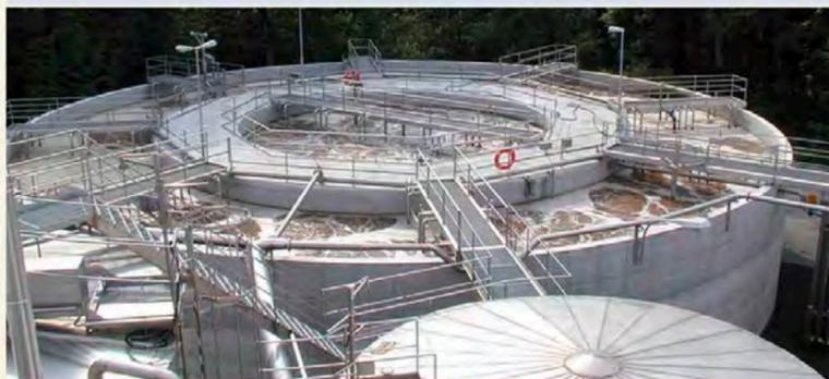
Bassin de station d'épuration avec bassin d'aération et paroi intérieure
