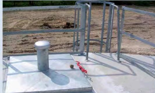
Accès au réservoir avec garde-corps sur la dalle de couverture et trappe d'accès
