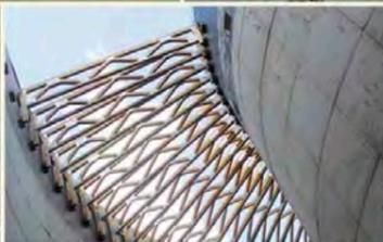
Nos systèmes de coffrage offrent une stabilité telle que nous sommes en mesure de monter nos coffrages intérieurs et extérieurs sans entretoises, ce qui nous permet de garantir une parfaite étanchéité de nos ouvrages.
