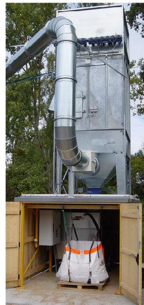
Filtre avec presse à briquettes
