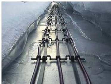
MAINTIEN HORS GEL CANALISATION & CHENAUX
