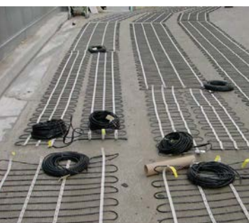
DÉNEIGEMENT DES VOIES D'ACCÈS
