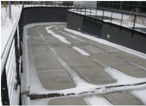
DÉNEIGEMENT DES VOIES D'ACCÈS
