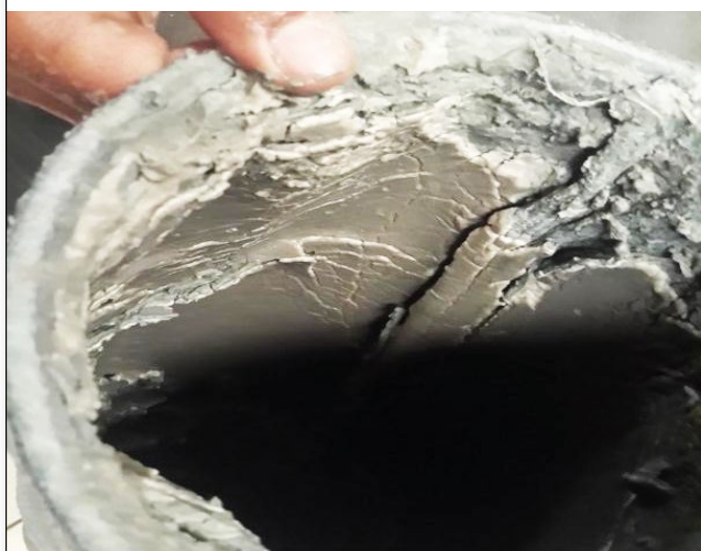
Sans Vulcan, le filtre était rapidement obstrué par les dépôts de calcaire et il devait être remplacé toutes les 48 heures.
