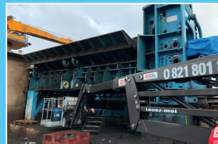
Remise à niveau de cisaille
