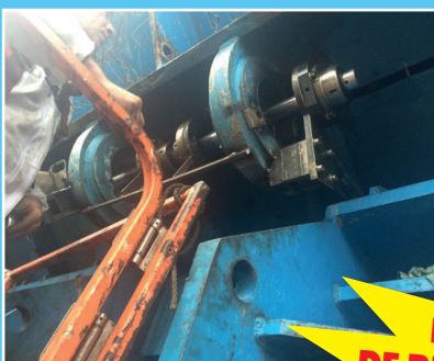
Usinage sur site
