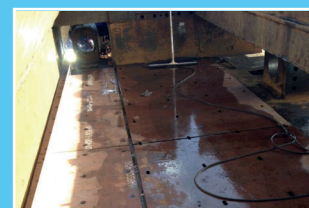
Remplacement et soudure tôles d'usure
