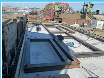
Fourniture et mise en place châssis mécano-soudé
