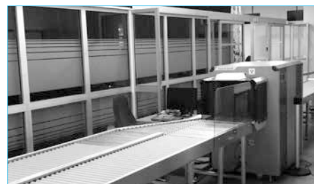
Postes d'Inspection Filtrage (PIF)
