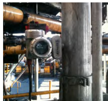
Mesure de concentration de sousverse d'épaississeur de résidus
