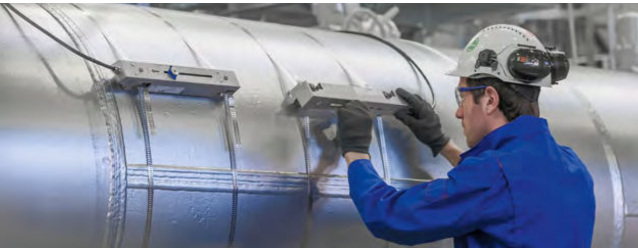
Appareil de mesure de débit à montage externe pour les conduites de grande taille
