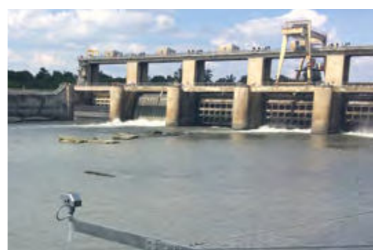
Mesure de niveau sans contact dans une centrale hydroélectrique
