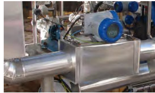
Mesure du débit et de la concentration pour la dilution de l'acide sulfurique
