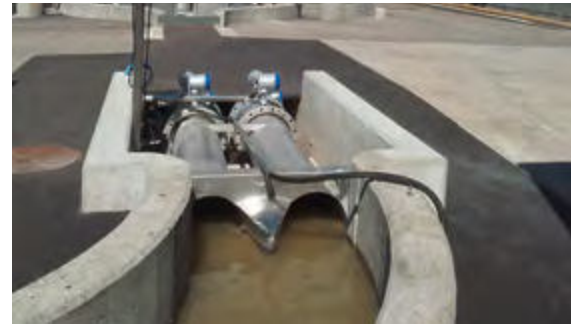
Mesure de débit des eaux usées dans les conduites partiellement remplies
