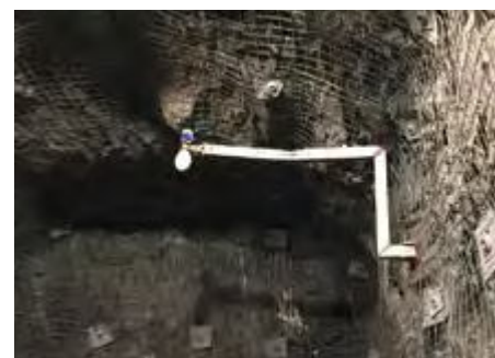
Contrôle du niveau dans une passe à minéral
