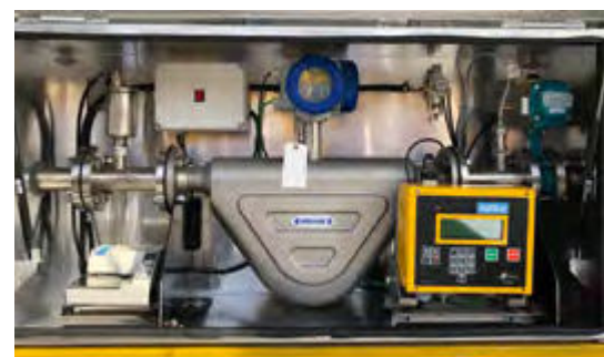
Comptage transactionnel d'AdBlue® des camions-citerne
