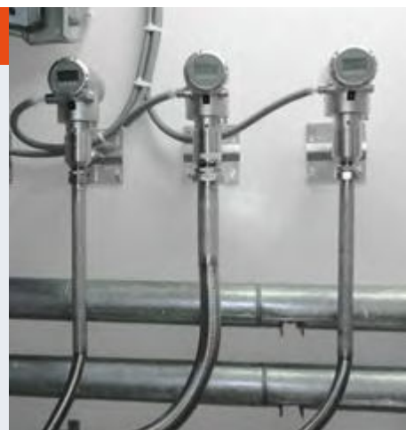
Mesure de niveau TDR sur condensats en milieu ionisant
