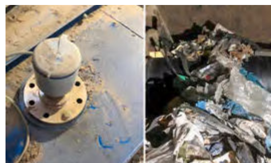
Mesure de niveau de déchets plastiques dans une station d'épuration
