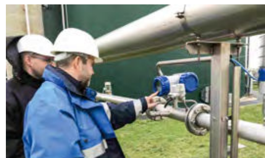
Mise en service de l'appareil réalisée par un technicien de services KROHNE
