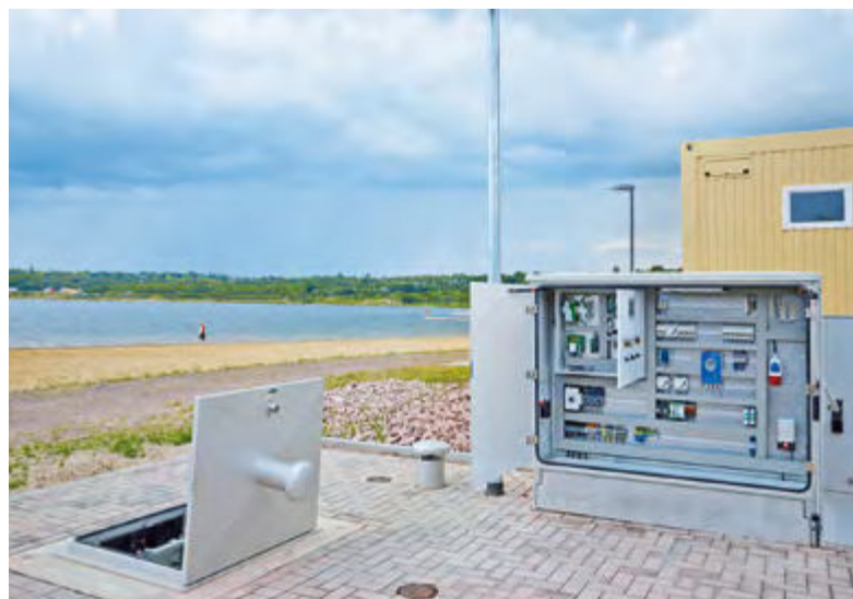
Mesure des désinfectants avec communication de données à distance
