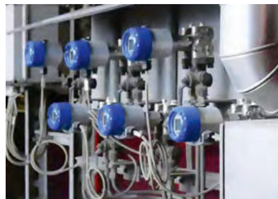
Transmetteurs de pression différentielle OPTIBAR DP 7060 dans une centrale d'énergie
