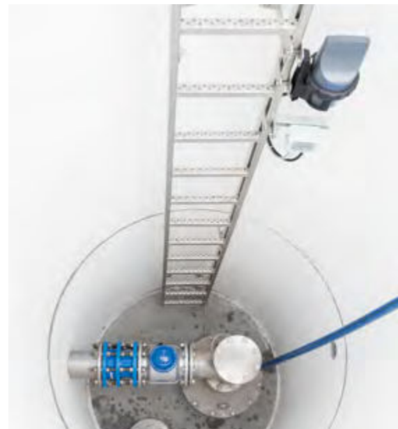
Point de mesure IP68 autonome avec communication GSM/GPRS
