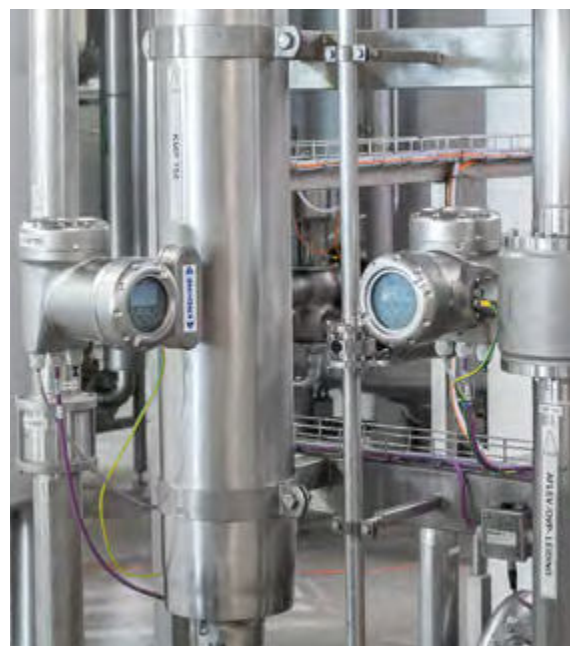
Débitmètre massique monotube droit OPTIMASS pour produits sensibles au cisaillement
