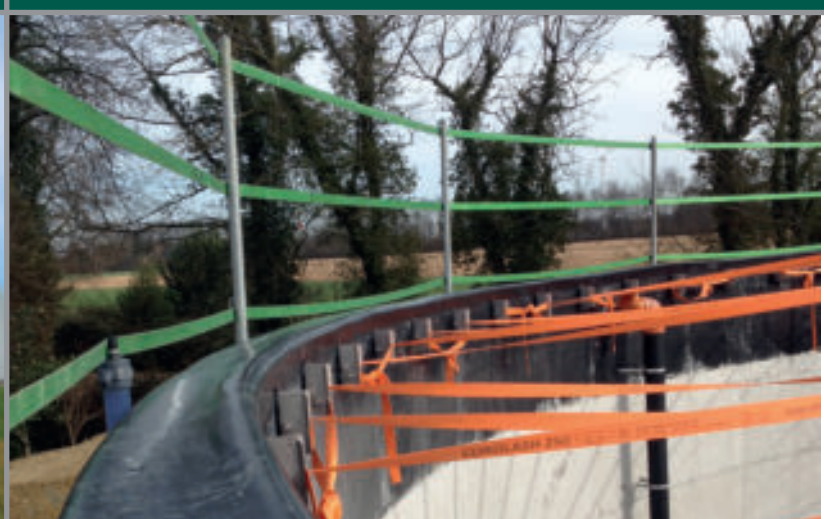
Protection en béton
