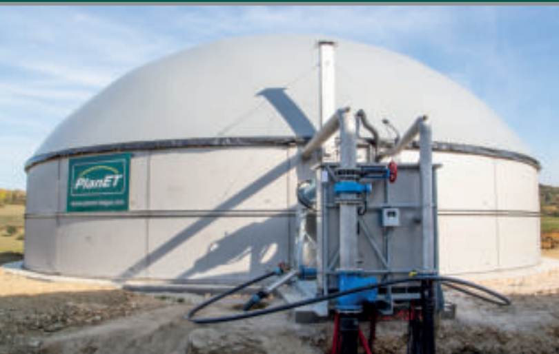
Réservoir en acier inoxydable - construction modulaire
