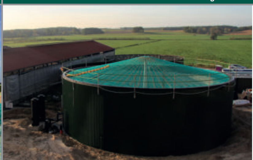
Construction du toit
