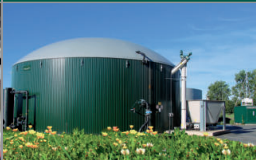
Installation à la ferme
