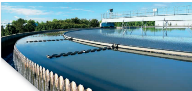
Traitement des déchets et eaux usées
