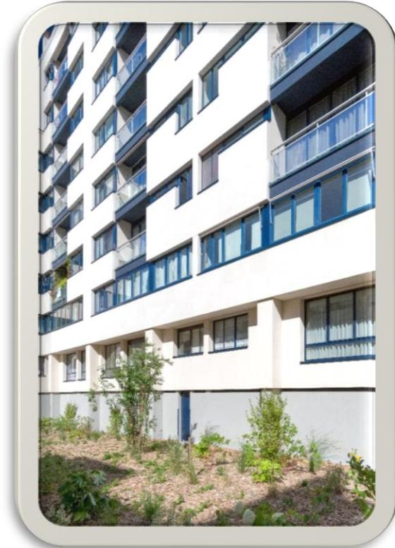
1 107 m<sup>2</sup> d'Isolation Thermique de 14 cm d'épaisseur
