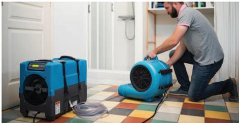
**Mise en place du matériel.** Pose de déshumidificateurs et de brasseurs d'air. Retrait éventuel des supports.
