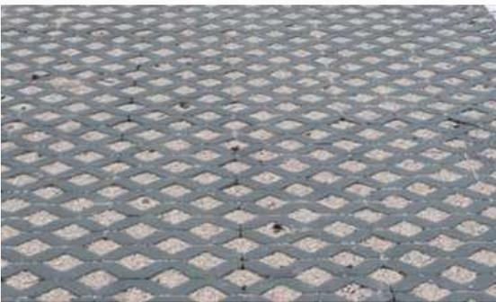
Dalle béton remplissage gravier
