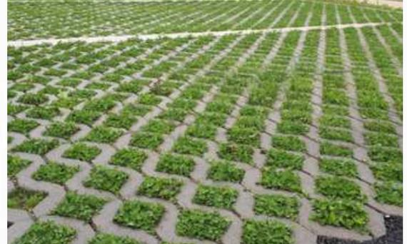
Dalle béton à enherber
