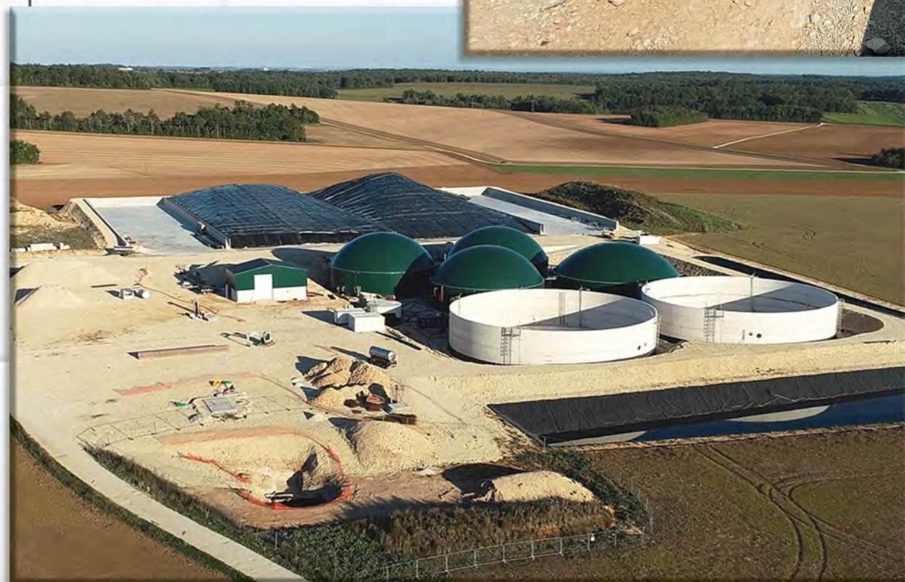
Vue générale d'un méthaniseur
