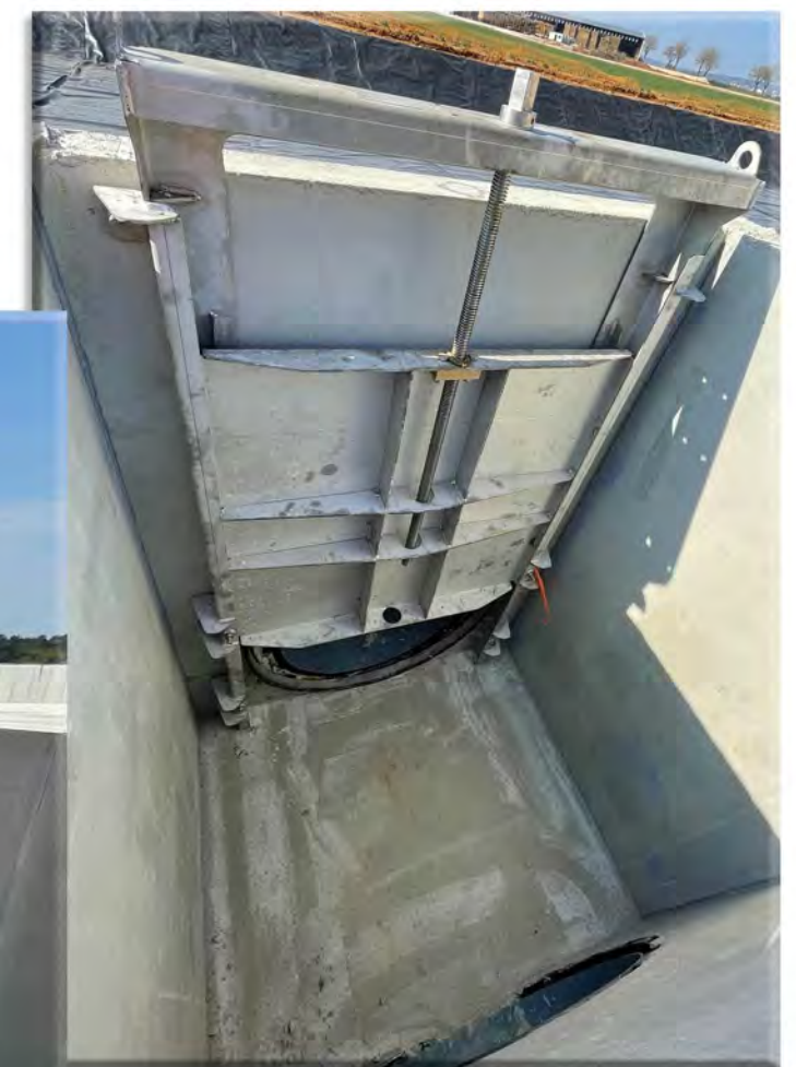
Création d'un regard préfabriqué pour accueillir une vanne DN1000
