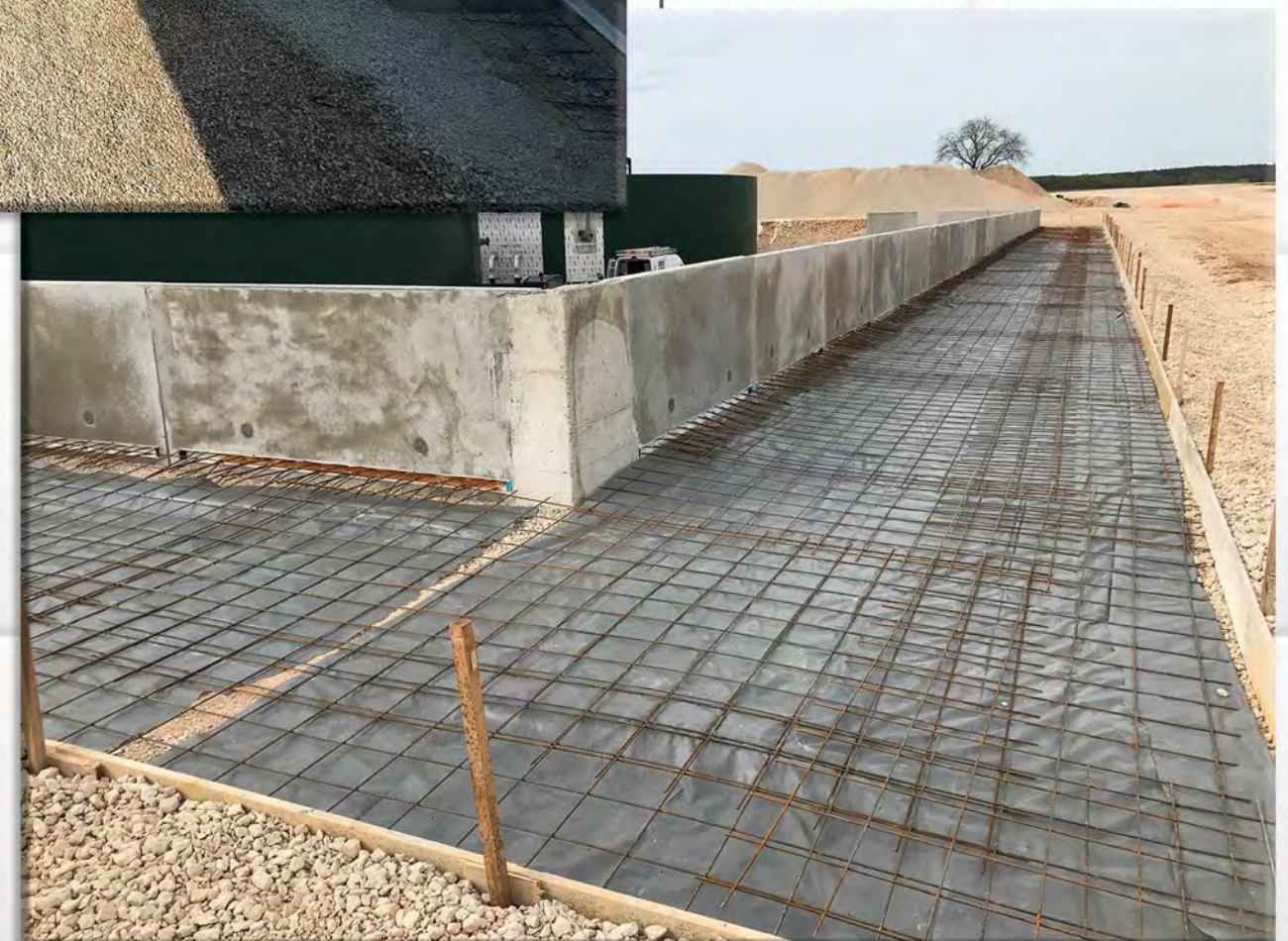
Création d'un mur de soutènement pour les trémies
