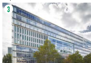
3 « Deichtor », Hambourg (Allemagne). Acquis en décembre 2019 (1)
