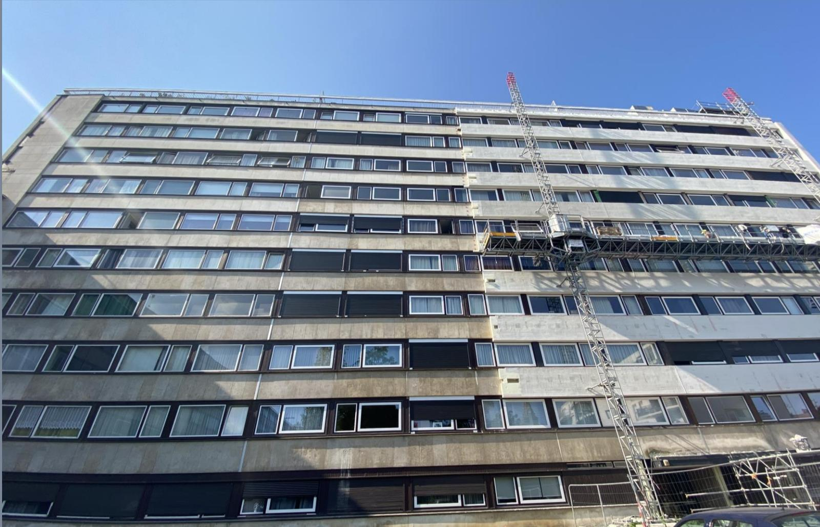
*La façade principale en cours de travaux. Ici la pose des isolants.*
