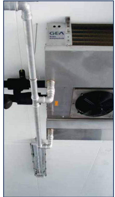
INSTALLATION EN SORTIE ÉVAPORATEUR
