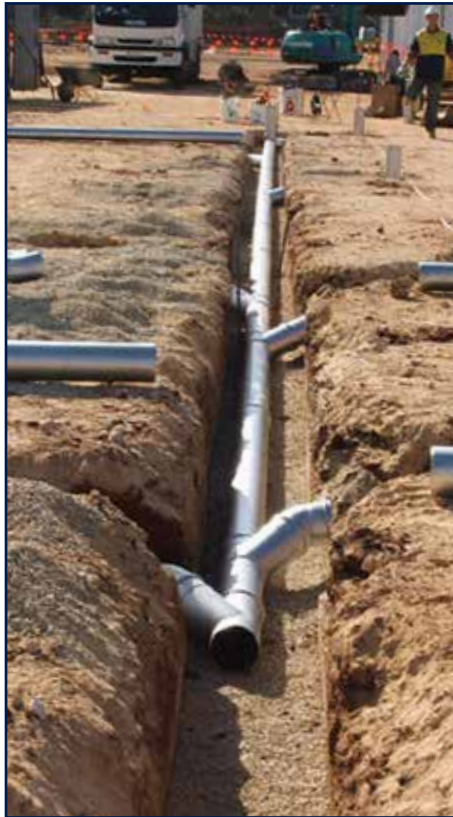
INSTALLATION EN ENTERRÉ
