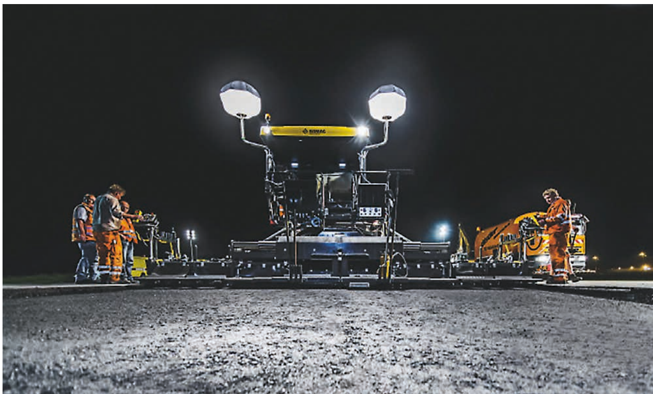
Une parfaite planéité – voilà le résultat. Cela se retrouve aussi dans ce chantier nocturne d'un aéroport réalisé en un temps record.
