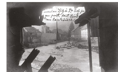
Inondations du 24 décembre 1919 à Sainte-Croix-aux-Mines.
