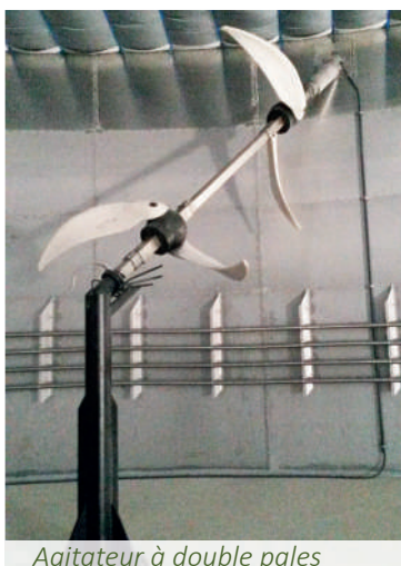
Vue intérieure d'un digesteur en acier inoxydable
