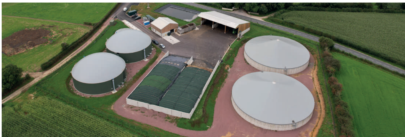
Picauville, Normandie Injection 100 Nm 3 /h biométhane
