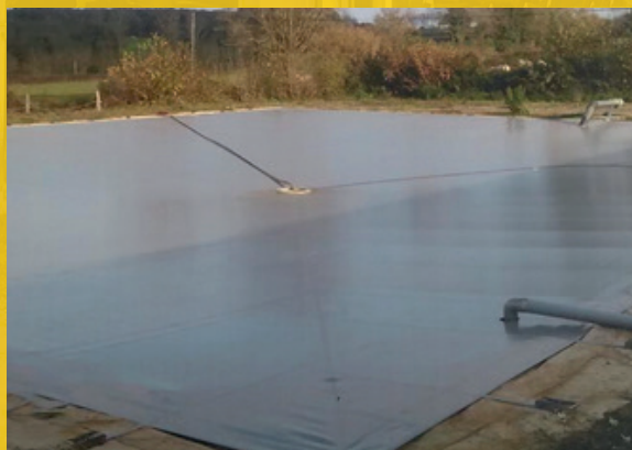
Couverture de lagune : flottante ou fixée
