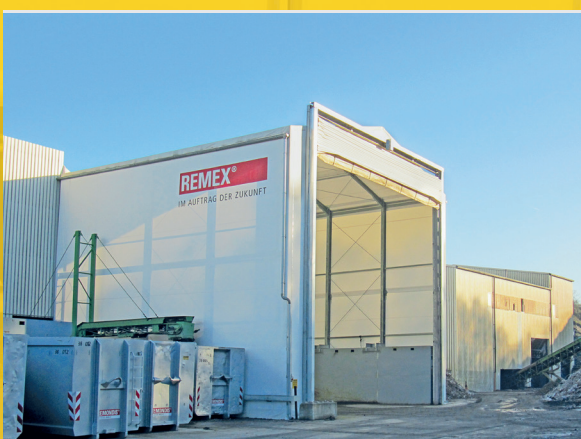
Hall pour le secteur du recyclage
