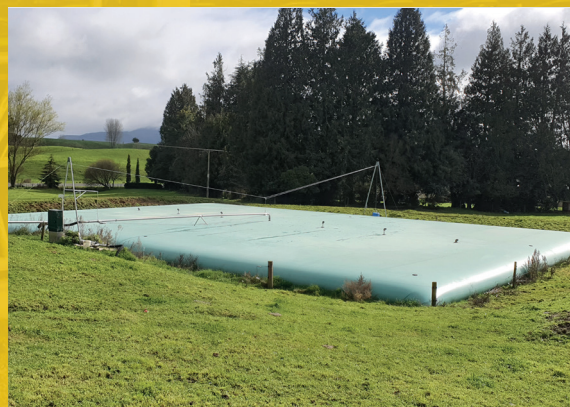
Réservoir d'eaux usées
