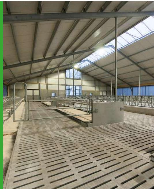
Moderne melkveestallen worden goed geventileerd voor een optimaal stalclimaat. Betonvloeren drogen hierdoor snel op. De profielen geven meer grip en zorgen ervoor dat de vloer minder snel opdroogt. Onze in-huis ontwikkelde profileringsmachine profileert de betonroosters fabrieksmatig voor een optimaal resultaat en een hoge duurzaamheid.
