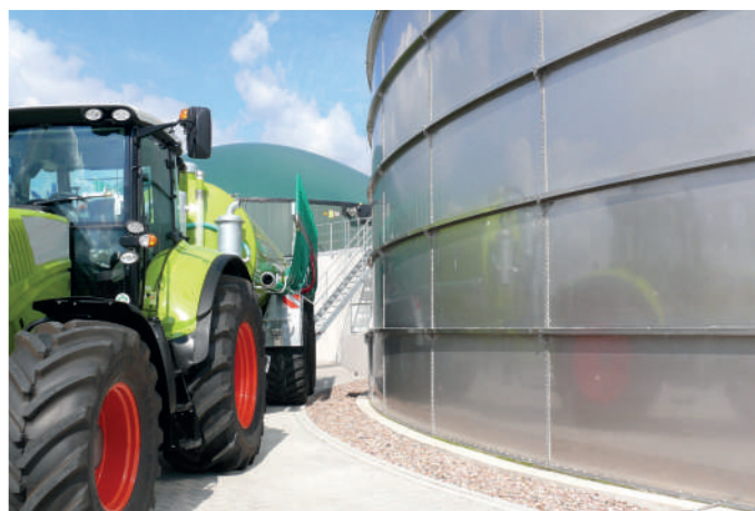
Cuve de stockage du digestat
