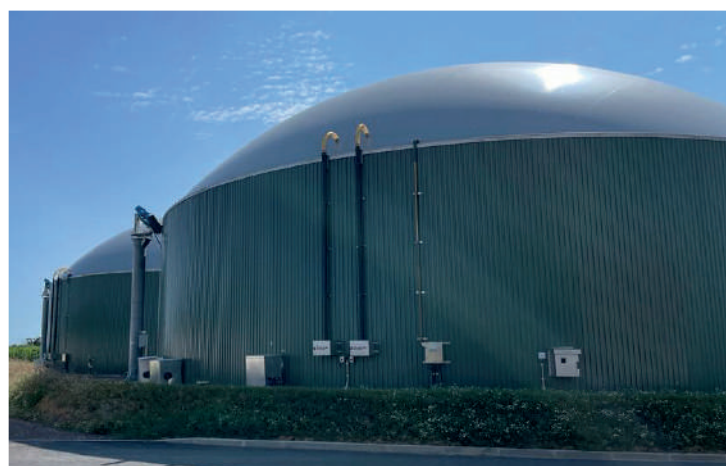
Digesteurs avec bardage
