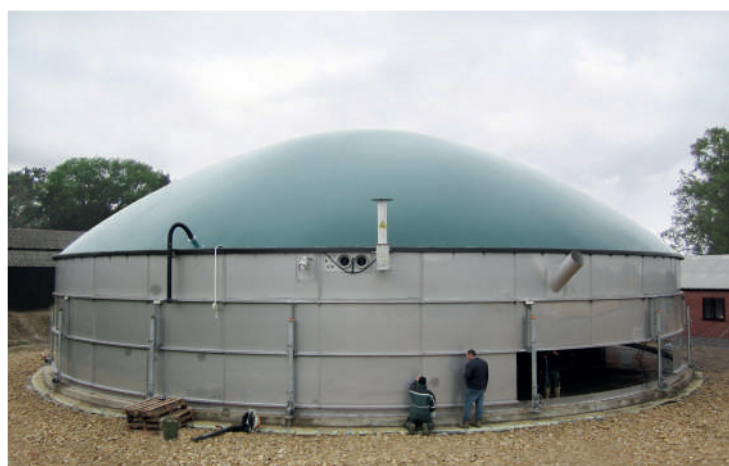
Construction du digesteur en acier inoxydable
