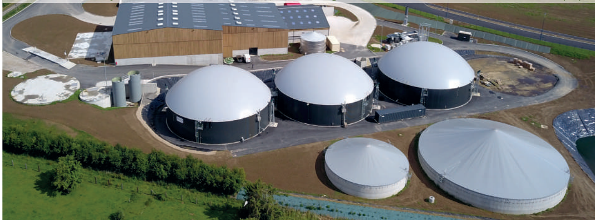
Installation avec injection biométhane de 250 Nm 3 /h CH 4 - 3 digesteurs de 4 436 m 3 et Ø 29,94 m - Calvados (14)
