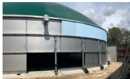
Les cuves sont assemblées étage par étage et poussées vers le haut à l'aide de vérins de levage.
