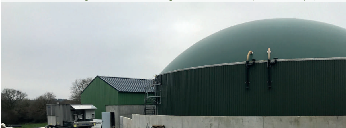
Installation en cogénération de 250 kW - 1 digesteur de 2 126 m 3 et Ø 20,73 m - Finistère (29)
