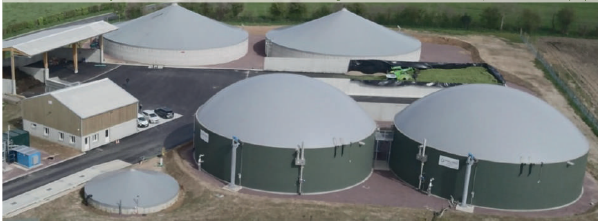
Installation avec injection biométhane de 100 Nm 3 /h CH 4 - 2 digesteurs de 3 176 m 3 et Ø 25,34 m - Manche (50)
