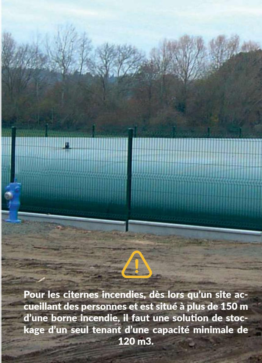
Pour les citernes incendies, dès lors qu'un site accueillant des personnes et est situé à plus de 150 m d'une borne incendie, il faut une solution de stockage d'un seul tenant d'une capacité minimale de 120 m<sup>3</sup>.
