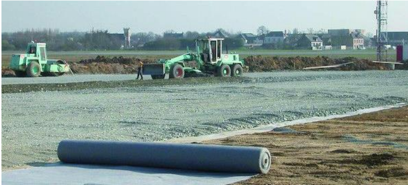
✓ Équipements pour le bâti
