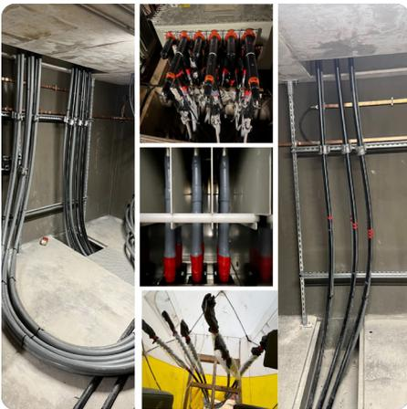
Nous entretenons ces compétences par la formation continue et nous travaillons sur des sections de câbles allant jusqu'à 1200mm<sup>2</sup>.
