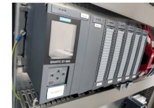
Programmation d'un automate Siemens S7-1500 et câblage de son armoire dans nos ateliers.
