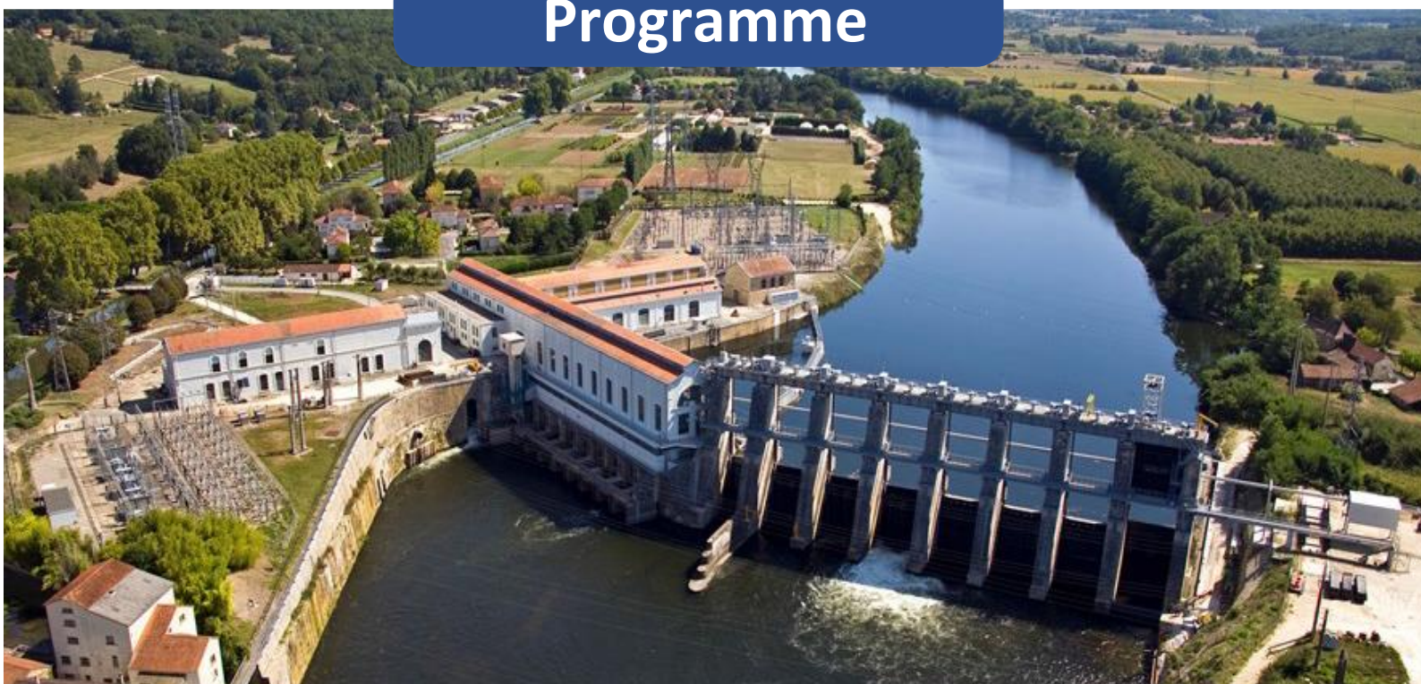
EDF- Barrage de Tuilières sur la Dordogne
