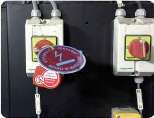
Les cadenas de condamnation interdisent la manœuvre de tout organe de séparation (un disjoncteur, une armoire ...). En laiton pour éviter toute corrosion, il est protégé par deux coques en plastique avec signalétique.
