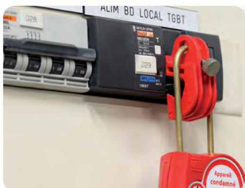
Les condamneurs de disjoncteurs interdisent la manœuvre des organes de coupure modulaires. La mise en place est simple, avec ou sans outils, condamnable par un seul ou plusieurs cadenas.
