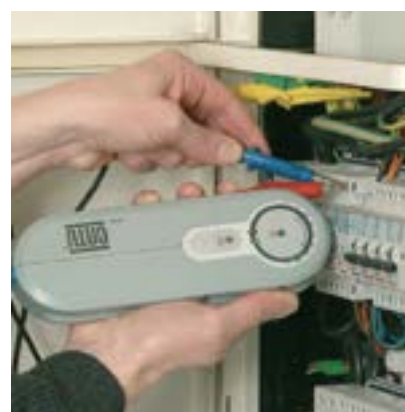
DT-500 sur installation consignée hors tension
