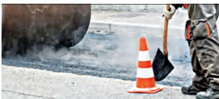
**9.** L'additif Cecabase RT® permet de fluidifier le bitume routier lors de sa pose. La température de chauffe est ainsi abaissée, ce qui permet de consommer moins d'énergie, de l'ordre de :
