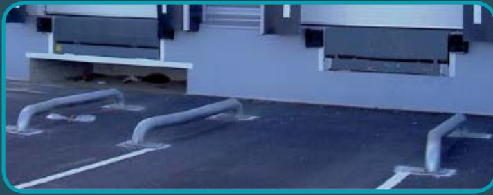
▲ Guides roues en acier galva : guide le Poids Lourd lors de sa manœuvre quelque soit la compétence du chauffeur.
